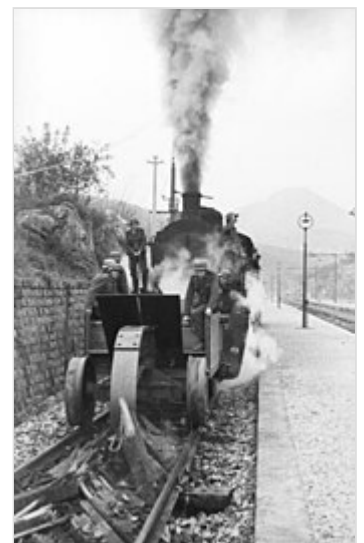
Italien 1944: Zerstörung von Bahngleisen mittels Schienenwolf
