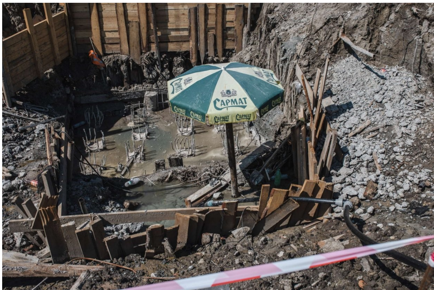
Arbeiter bauen Häuser und eine Brücke in der Stadt Sviatohirsk wieder auf, die von russischen Truppen zerstört wurden, in der Region Donetsk Ukraine am 20.7.2023 aufgenommen. (© picture-alliance, AA, Gian Marco Benedetto)
